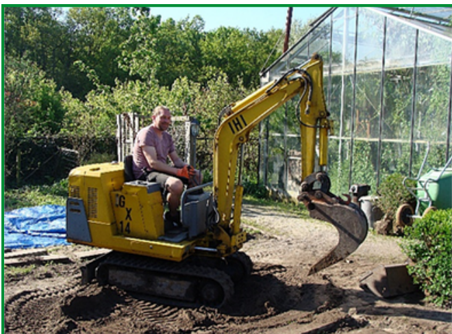
Grondwerkzaamheden bij het logeershuis
